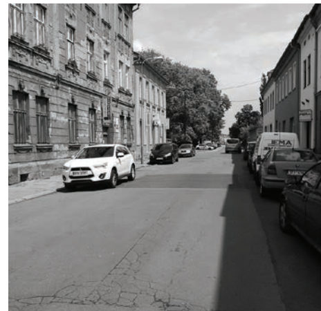
Počítá se také s rekonstrukcí ulice Šalounovy.
